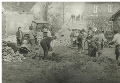
Rozbiórka budynków gospodarczych, 1988 r.
