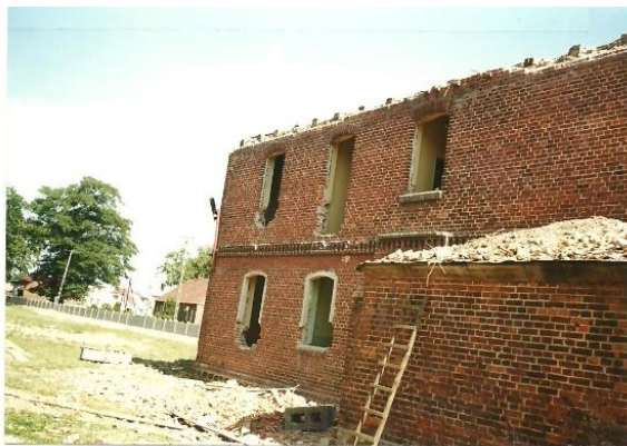
Rozbiórka starej czerwonej szkoły, 1999 r.
